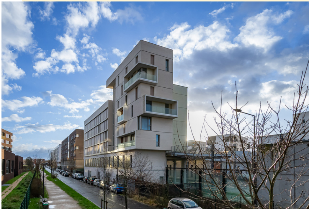
La résidence-FJT 4 Pépinières de l'ALJT (Vitry-sur-Seine)
